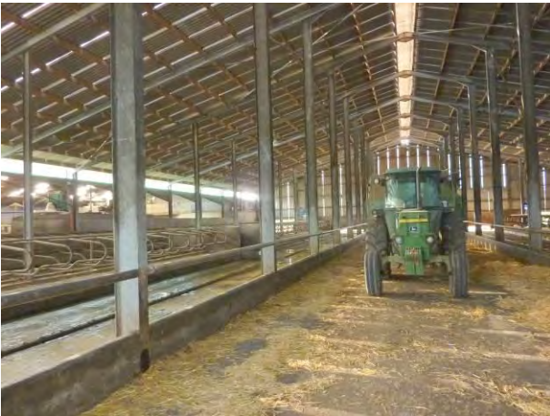
Figur 72 Bygninger med stålrammer og stolpekonstruktion.
