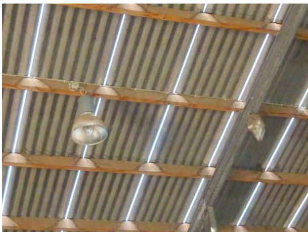
Figur 74 Sprækker imellem tagpladerne udgjorde en del af ventilationen.
