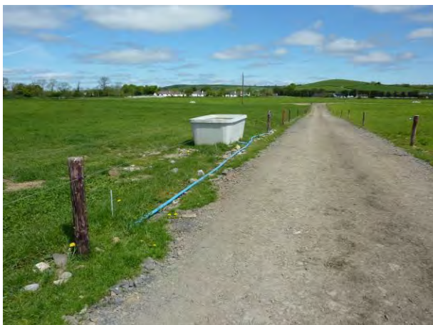
Figur 13 Drivvej belagt med skifferlignende sten, som knuses med tiden. vejene anvendes både af dyr og maskiner.
