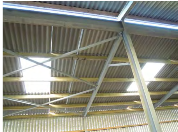
Figur 73 Der var cementtagplader på træåse, stålspærene var stabiliseret med kryds.
