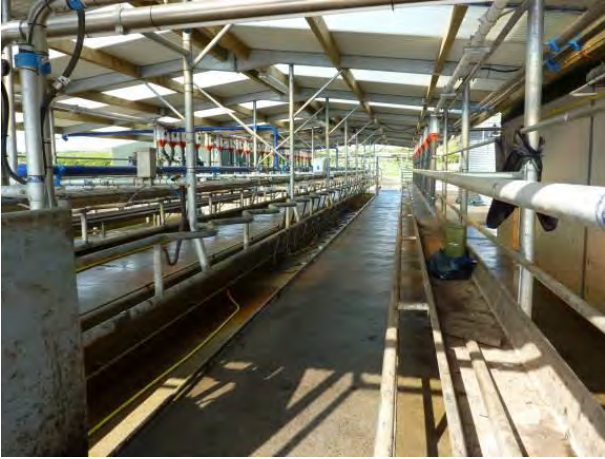
Figur 25 Malkestald med 24 pladser og swing-over, forberedt til 30 pl.
