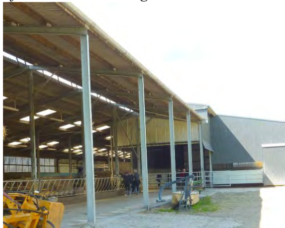
Figur 14 Sengestald til venstre, bagerst: malkestald til venstre og kælvnings- og kalvestald til højre.
