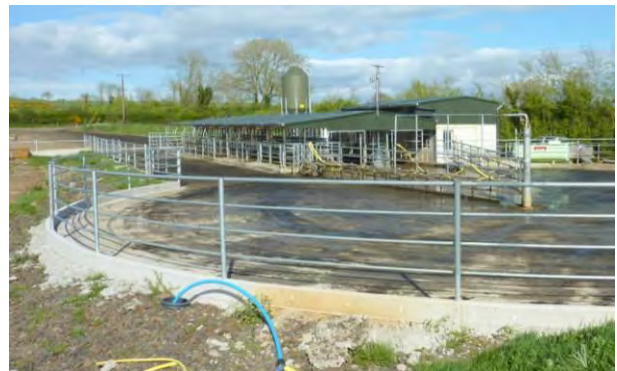
Figur 28 Dairy master malkestald: 2 x 24 pladser m. swing-over, i en bygning der egentlig kun har et uisoleret tag af stålplader ("cykelskur"-bygning) og med rund opsamlingsplads – hvor opsamlingspladsen vaskes med genbrugsvand fra pladekøleren, når bommen kører retur.
