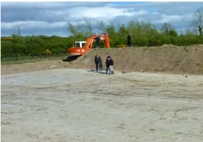
Figur 36 Ensilageplads med jordvold omkring, netop færdig anlagt.
