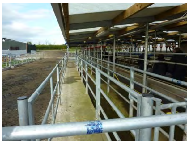
Figur 40 I behandlingsgangen er der adgang til dyrene både forfra og bagfra.
