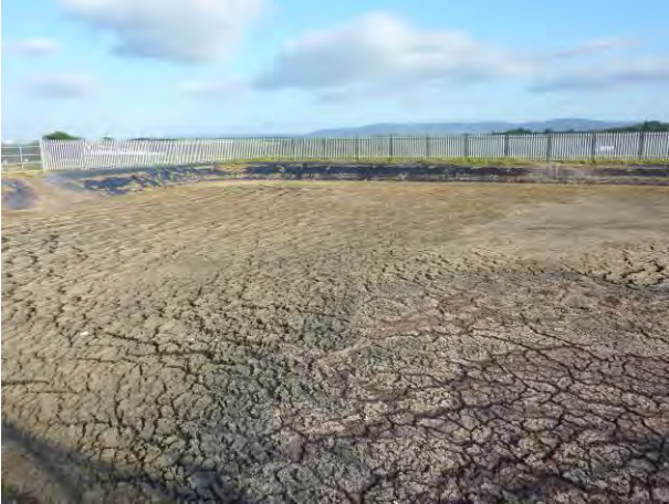
Figur 70 Gyllelagune på 4.500 m 3 , koster kun det halve af en betongyllebeholder.
