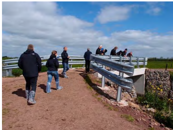
Figur 52 Stabilt vejmateriale der ikke bærer præg af, at regnen silede ned dagen før.
