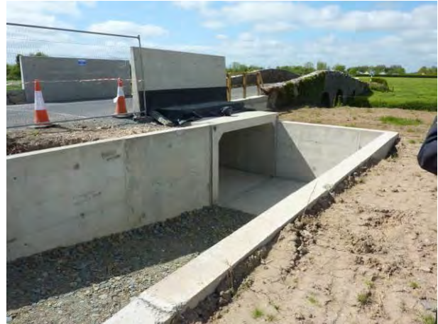
Figur 55 Kvægtunellen under vejen, ved siden af den gamle stenbro over floden, pris 130.000 kr.
